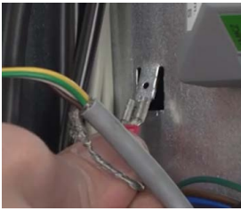
Afscherming van de canbuskabel
